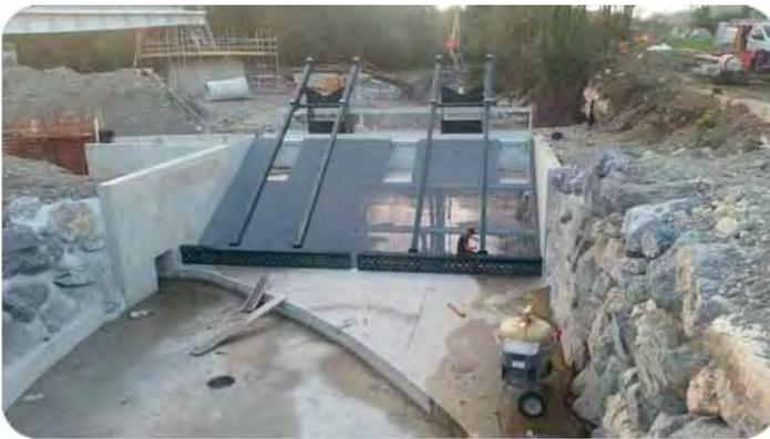
Conception et fabrication de dégrilleurs, grilles et systèmes de dévalaison pour ouvrages hydrauliques
