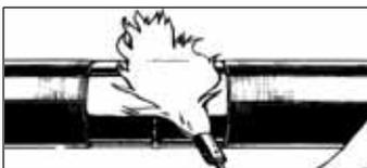
Préparer la surface du tube à recouvrir. A l'aide d'une torche propane, amener à environ + 60°C la température de la surface à recouvrir.
