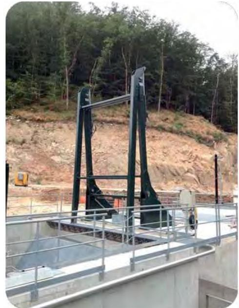
Dégrilleurs hydrauliques sur mesure
