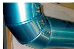
**Domaine d'application** : Isolation des appareils et des tuyauteries d'eau glacée ou de fluides négatifs jusqu'à -65°
